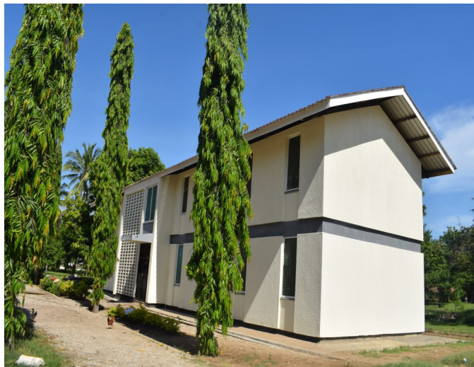
Jengo la Bweni liitwalo Mwenge jinsi linavyoonekana baada ya ukarabati katika Shule ya Sekondari
