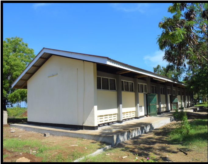
Jengo la madarasa liitwalo Jigrafia linavyoonekana mara baada ya ukarabati.
